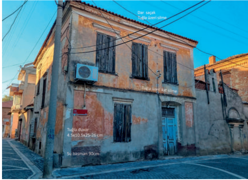
Şekil 28: 73 Ada 18 Parsel, Dış duvarları kâgir, iç duvarlar ahşap karkas ve döşemesi ahşap olan konut.
