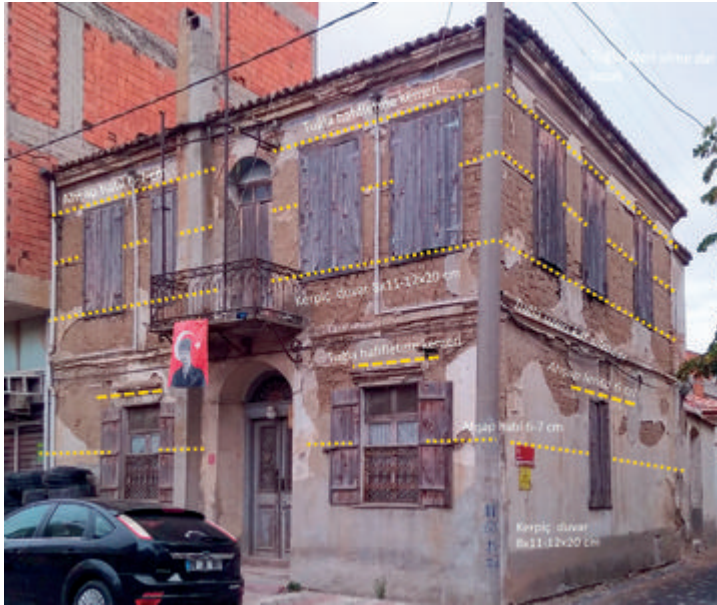
Şekil 28: 73 Ada 18 Parsel, Dış duvarları kâgir, iç duvarlar ahşap karkas ve döşemesi ahşap olan konut.
