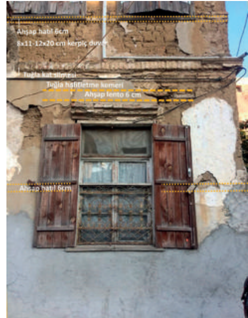
Şekil 29: 114 Ada 50 Parsel, Dış duvarları kerpiç+ahşap hatıllı, iç duvarları ahşap karkas ve döşemesi ahşap olan konut.
