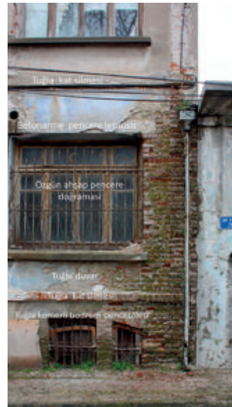
Şekil 31: 36 Ada 26 parsel, dış duvarları kâğır, iç duvarlar ve döşemesi ahşap, lentoları ahşap, kâğır duvarları demir gergili sistem.
