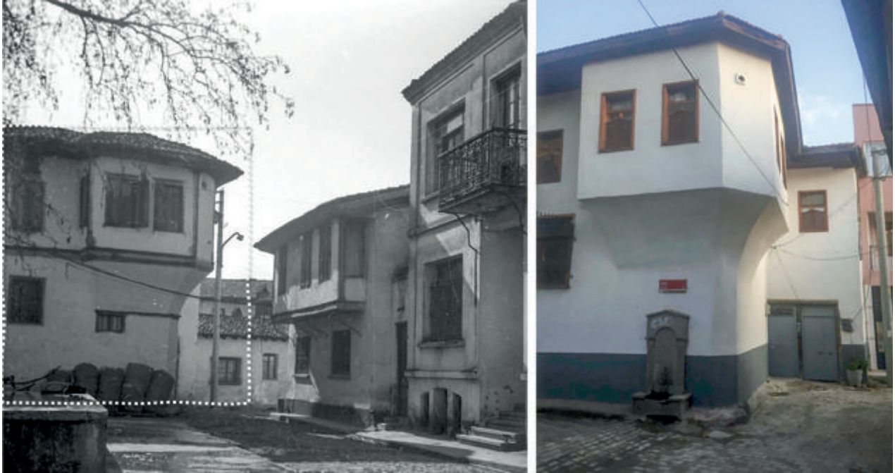
Şekil 32: 204 Ada 5 Parsel'deki yapının 1973 yılındaki ve 2019 yılındaki görüntüsü (MSGÜ-RADA).
