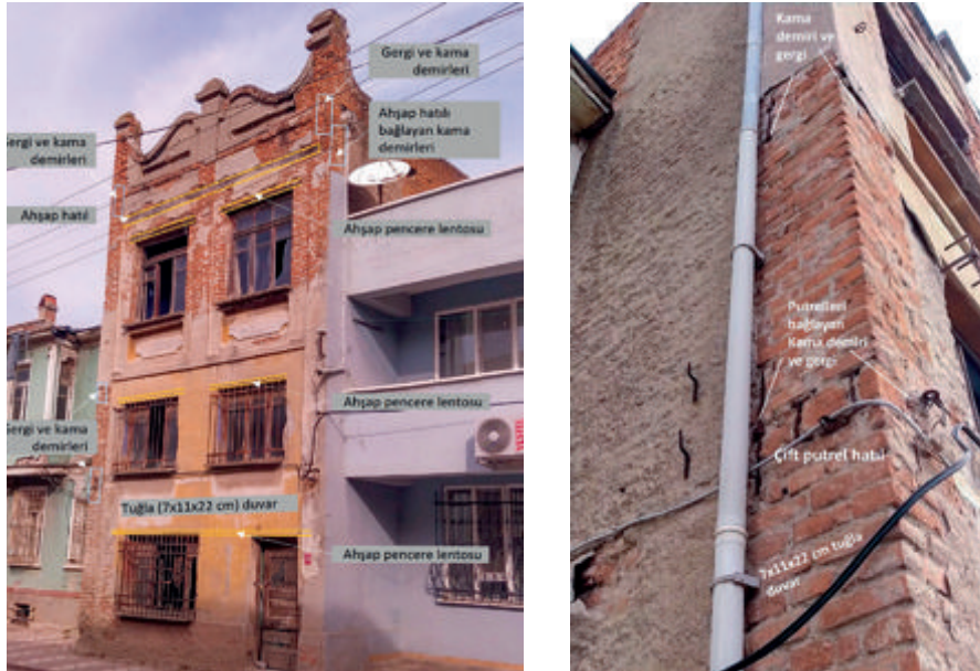
Şekil 31: 36 Ada 26 parsel, dış duvarları kâğır, iç duvarlar ve döşemesi ahşap, lentoları ahşap, kâğır duvarları demir gergili sistem.
