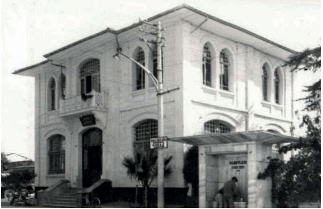
Şekil 4: Havran Belediye Binası'nın 1960'lı yıllardan bir görünümü (Havran Belediyesi Arşivi).
