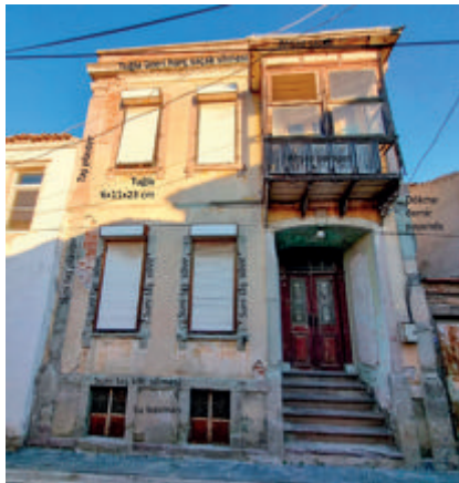
Şekil 27: 74 ada 23 Parsel, dış duvarları karma (tuğla+ahşap karkas arası dolgu), iç duvarları ahşap karkas ve döşemesi ahşap.
