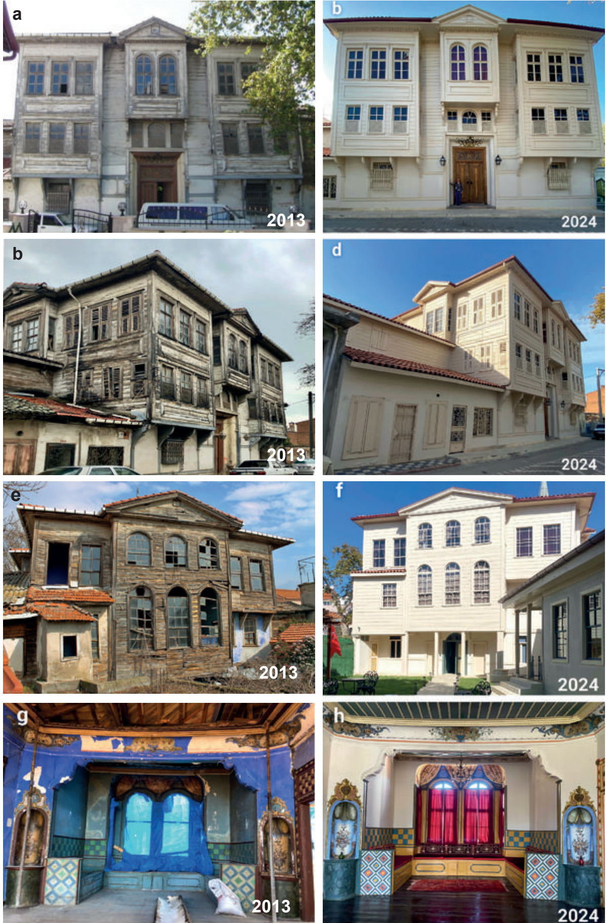
Şekil 25: Havran Terzizade Konağı onarım öncesi (solda) ve onarım sonrası (sağda) görselleri (MSGÜ-RADA).
