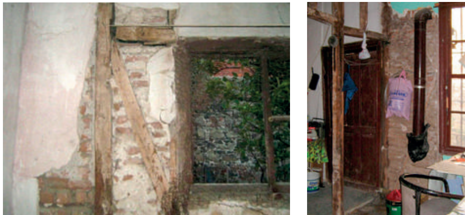
Şekil 9: 74 ada 20 parseldeki yapının iç görünüşleri (2010).
