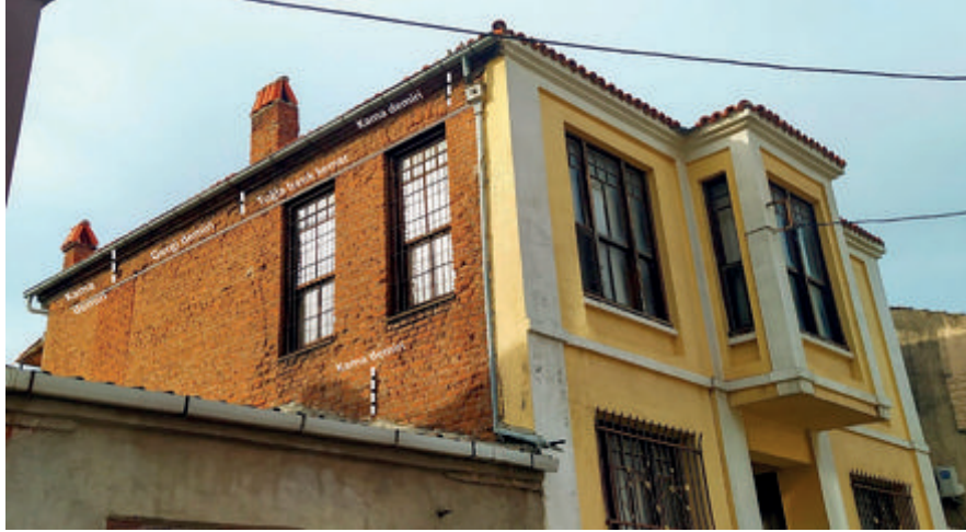
Şekil 30: 206 Ada 7 Parsel, Dış duvarları tuğla, iç ahşap duvarlar ve döşemesi ahşap, demir gergili sisteme sahip konut.
