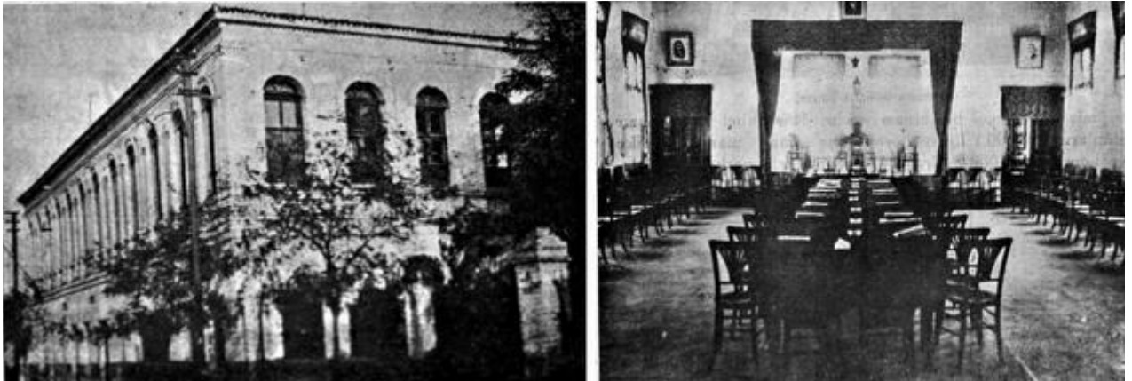
Şekil 5: Havran Halkodası Binası (Yetkin 1939, s.35-36).
