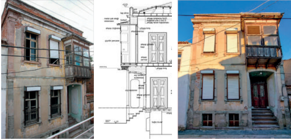
Şekil 8: 74 ada 20 parseldeki yapının 2010 yılındaki cephesi, sistem kesiti ve 2023 yılındaki görünümü.
